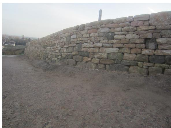
A l'occasion d'un renouvellement de ceps de vigne, le propriétaire du domaine a souhaité faire reconstruire un vieux mur de soutènement en mauvais posture par un mur correctement dimensionné et adapté à l'usage des engins actuels.
