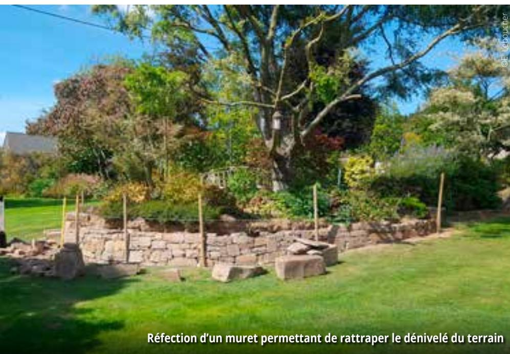
Réfection d'un muret permettant de rattraper le dénivelé du terrain
