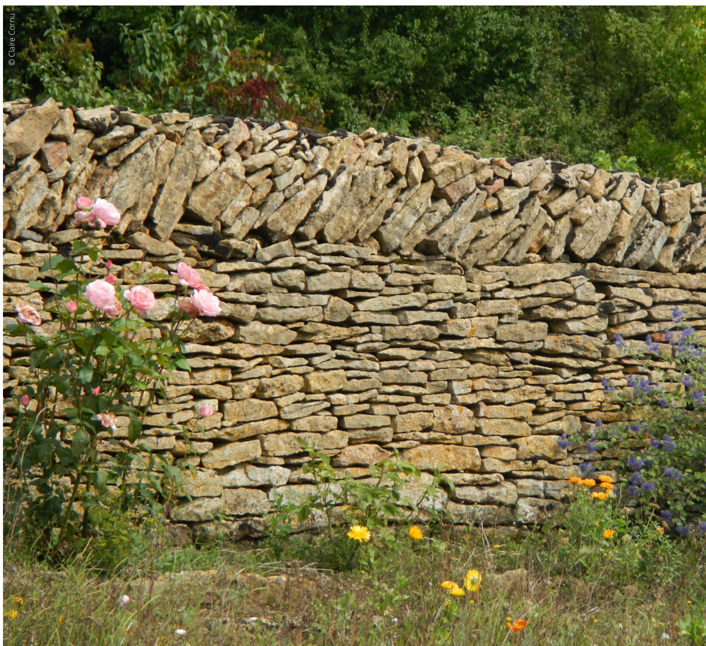
MUR DE CLÔTURE EN BOURGOGNE
