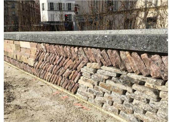
Détails de l'appareillage
