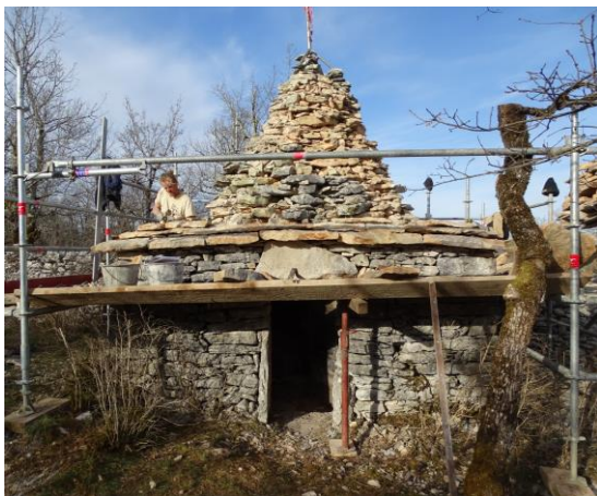
Echafaudage, démontage de la toiture endommagée et remplacement des lauzes d'égout
