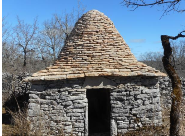
Le chantier terminé.
