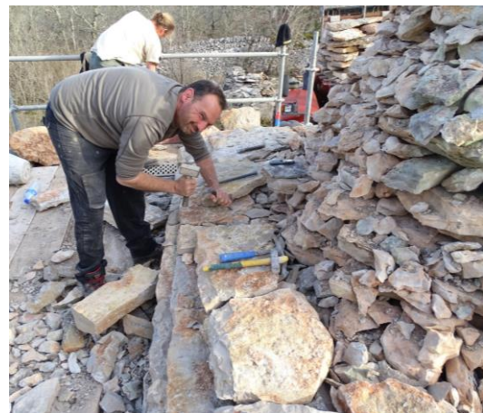
Echafaudage, démontage de la toiture endommagée et remplacement des lauzes d'égout
