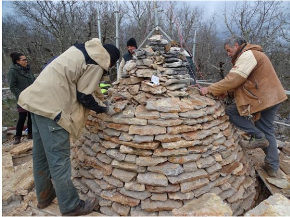
Reconstruction de la toiture
