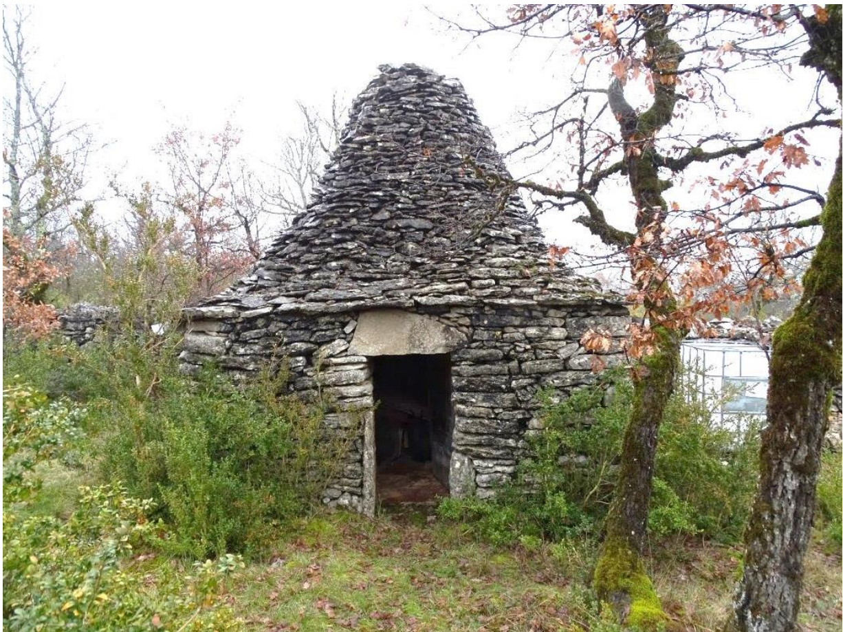
Caselle dont la toiture nécessite une remise en état complète Commune de Marcilhac-sur-Célé (photo prise en septembre 2018)
