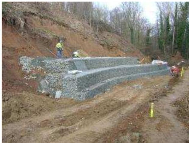
Figure 12: Chantier en cours de réalisation utilisant la technique du gabion
