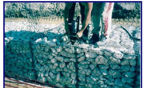
Avant remplissage, un cadre de guidage est mis en place sur les faces vues. Ce cadre en tube métallique permet un maintien plan de ces faces et évite qu'elles soient bombées. Les pierres sont ensuite disposées manuellement sur les faces vues afin d'assurer un aspect soigné, régulier et avec le moins de vides possible. L'opération est ainsi renouvelée pour chaque couche, la dernière étant remplie en léger excédent afin que le couvercle soit bien tendu
