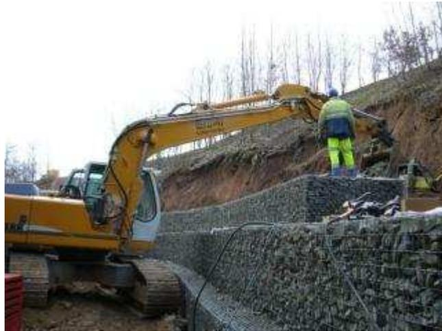
Figure 18: Tractopelle remplissant les gabions
