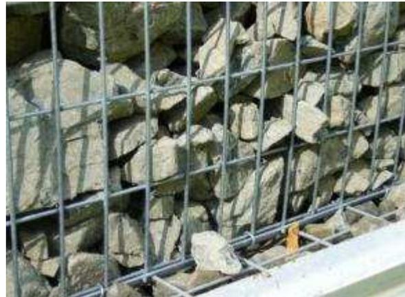
Figure 14: Gabions électrosoudés
