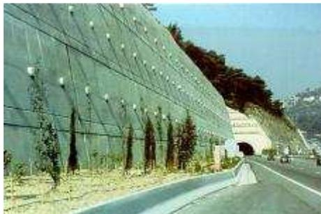
Figure 24: Exemple de mur cloué
