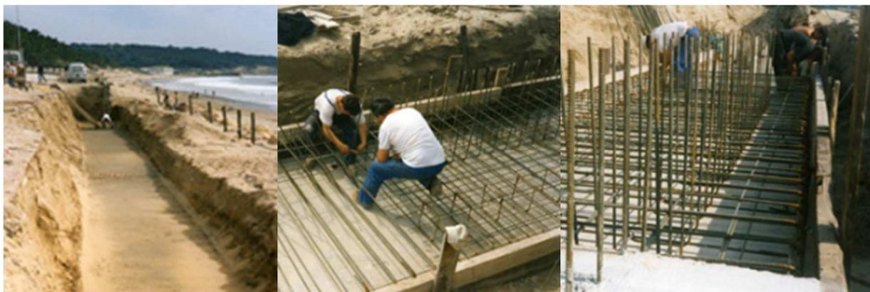
Figure 32: Etapes de la construction d'un mur de béton en L
