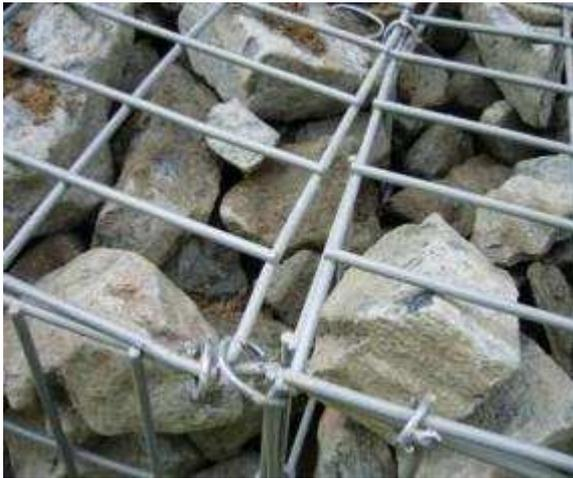
Figure 16: Agrafes entre les différents panneaux
