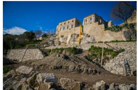
Terrassement et implantation des systèmes d'alignement - mars 2020
