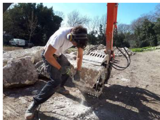
Façonnage du parement au burineur pneumatique
