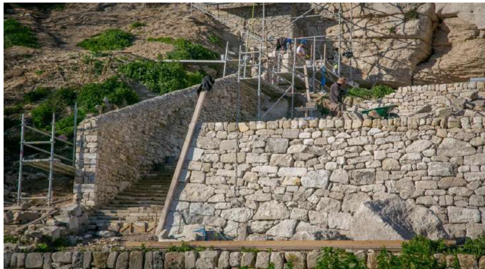
Vue des différents ouvrages et échafaudages attenants à l'escalier ouest - avril 2021
