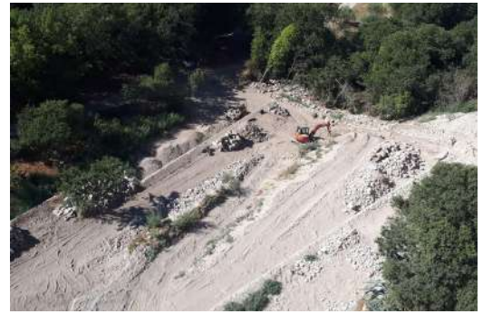
Travail de terrassement avec vue sur les accès créés pour la pelle mécanique - août 2020
