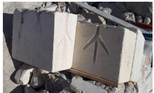
Pattes d'oies creusées dans les claveaux
