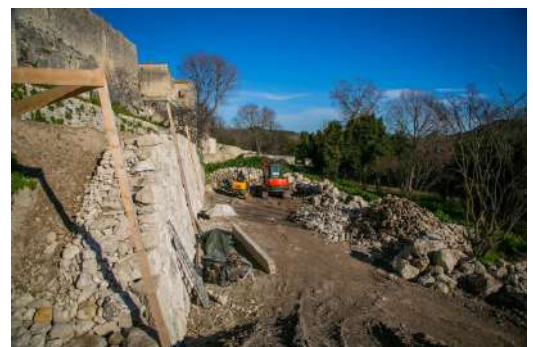
Tri des pierres à la pelle mécanique - mars 2020
