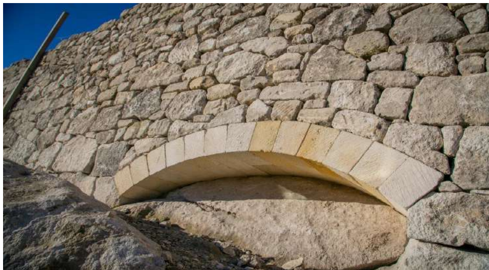
Arc en pierre de taille, en pied de mur - avril 2021
