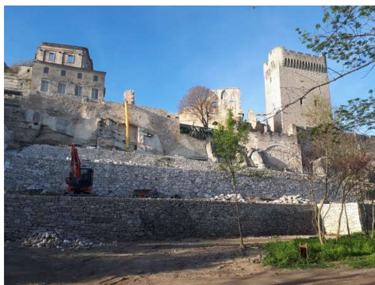
Fin des travaux - Mars 2021
