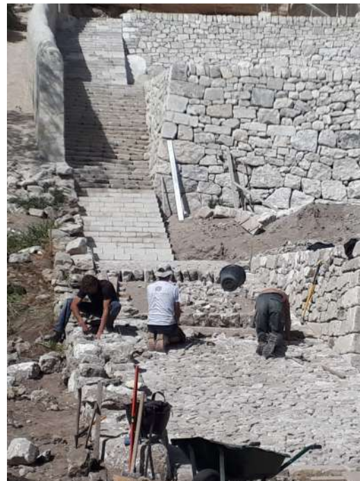
Escalier ouest et rampe caladée - avril 2021
