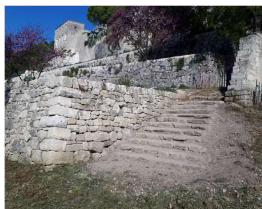
Chaîne d'angle et escalier caladé - avril 2021
