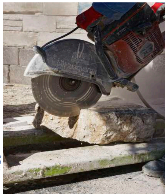
Découpe des pierres à la disquette thermique
