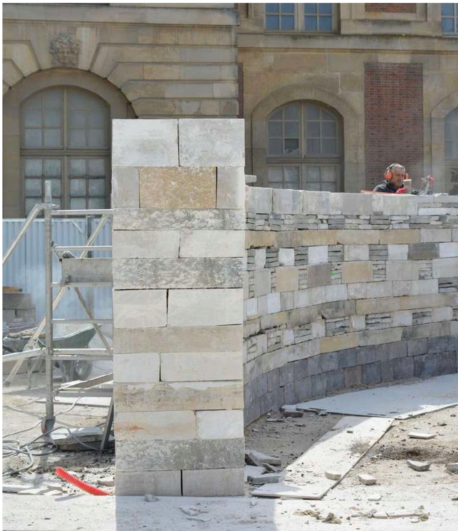
Tête de murs, parements interne et externe du mur
