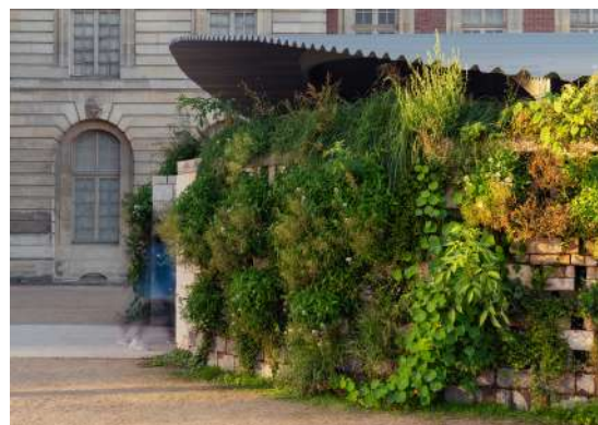
Vue, 4 mois après la fin des travaux
