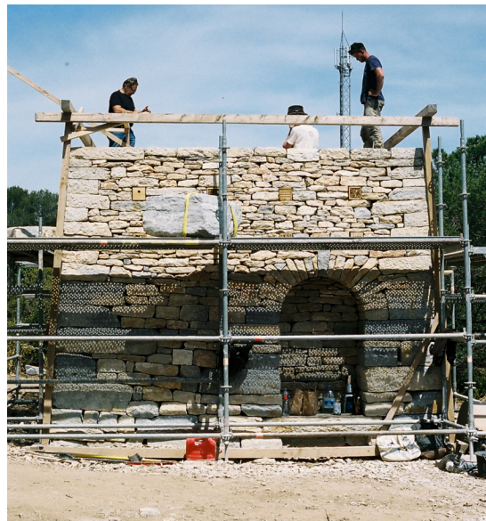
Fin du chantier - © Replica Architecture
