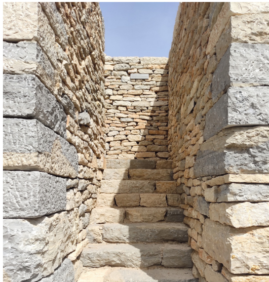
L'escalier d'accès à la terrasse © Replica Architecture
