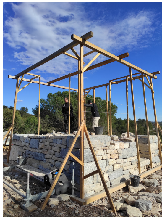
Aperçu du chantier - © Replica Architecture
