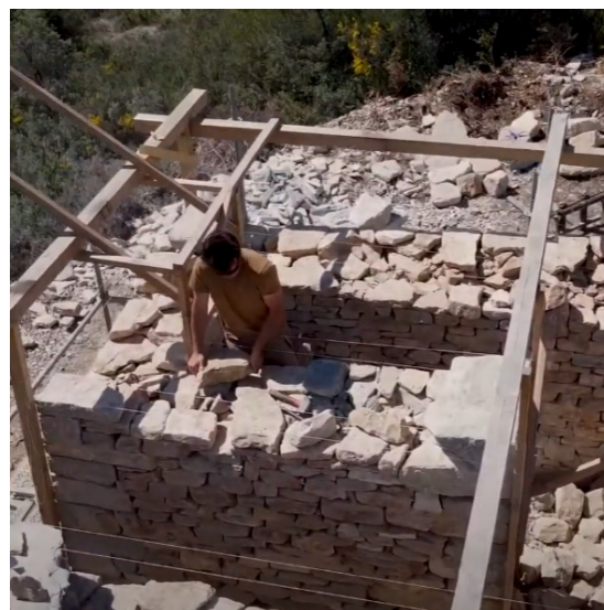
Aperçu du chantier - © Nans Soulé-Beaud
